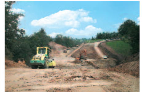
Chantier RD 617 Course du Mouton/Moynac
