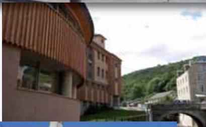
Centre Thermal de Chaudes-Aigues Contribution du Conseil Général : 3 980 000 €
