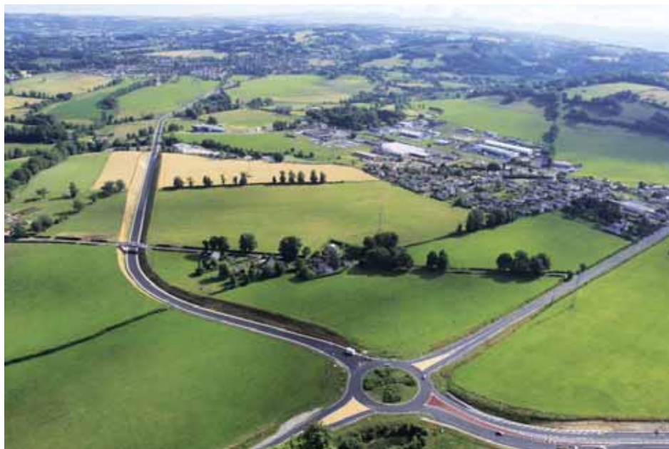
Vue aérienne de la déviation des Quatre-Chemins
