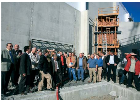
Visite du chantier de la halle communautaire à vocation culturelle et économique à Aurillac
